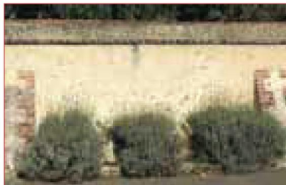
Mur de clôture en bauge avec chaperon maçonné et contreforts en brique. Escorpain.
